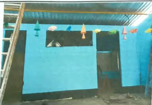
Foto 1: Colocación de lamina lisa a ventanas y reparación de dos puertas de metal
