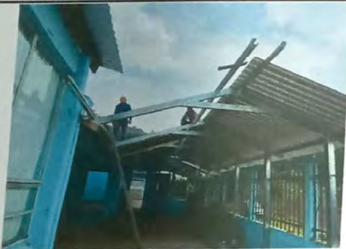
Foto 3: SUMINISTRO DE LAMINA
