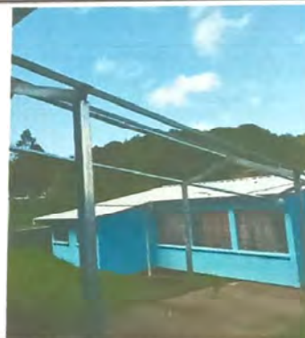
Foto 4: Suministro de lámina Troquelada y soporte de metal
