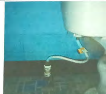
Foto 2: Sustitución de manguera de tanque de un servicio sanitario
