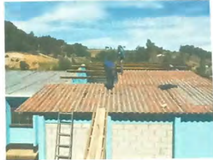
Foto 2: SUSTITUCION DE LAMINA
