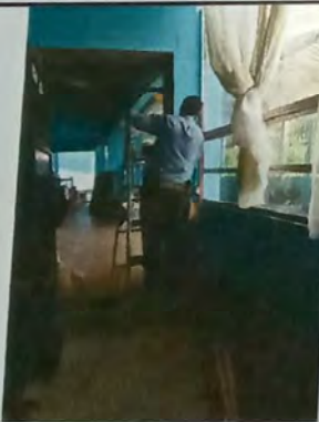
Foto 5: REPARACION DE SISTEMA ELECTRICO
