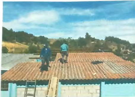
Foto 1: SUSTITUCION DE LAMINA
