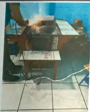
Foto 3: Sustitución de plancha de leña de tres hornillas
