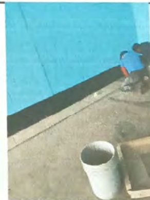
Foto 6: SUSTITUCION DE PISO CERAMICO
