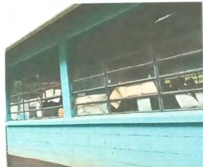
Foto 4: SUSTITUCION DE ESTRUCTURA DE METAL DE VENTANA
